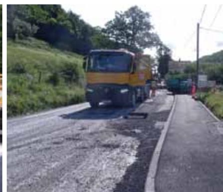
**Rue d'Helvétie** : remplacement de la canalisation d'eau potable/Protection Incendie mise aux normes. Reprise des branchements des riverains (y compris Ecurcey)
